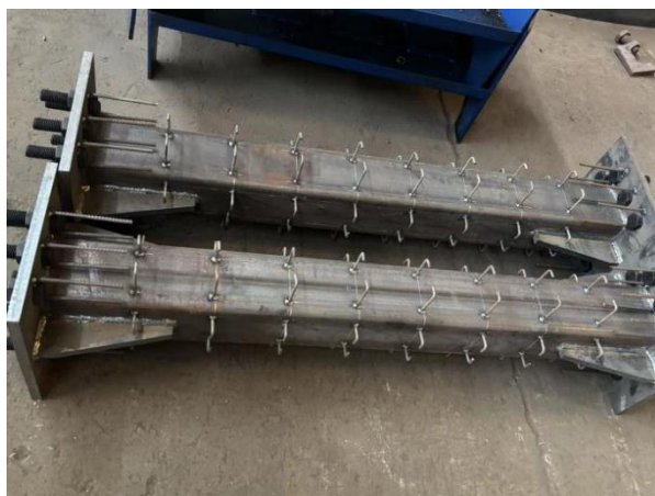
图 2 新型钢管混凝土立柱
