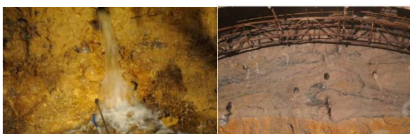
图2 青岛地铁富水砂层注浆治理
